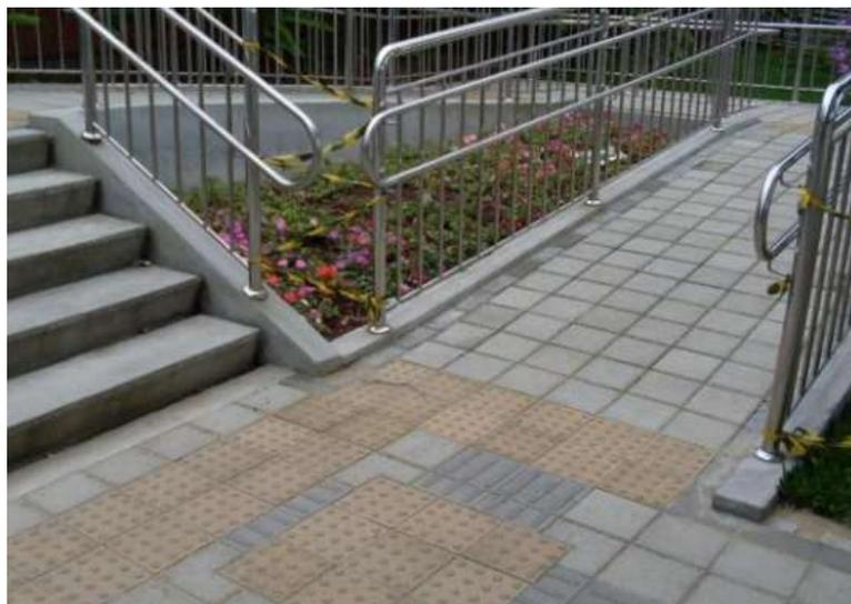
**Figura 32 - Instalação de Piso Tátil e Rampa (Proj. Milena Mesquita Galvão, 2010)**
