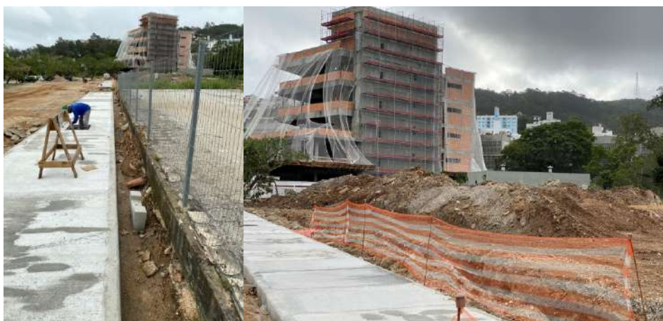
Figura 43 – Bloco Administrativo do CFM – Obra em execução
