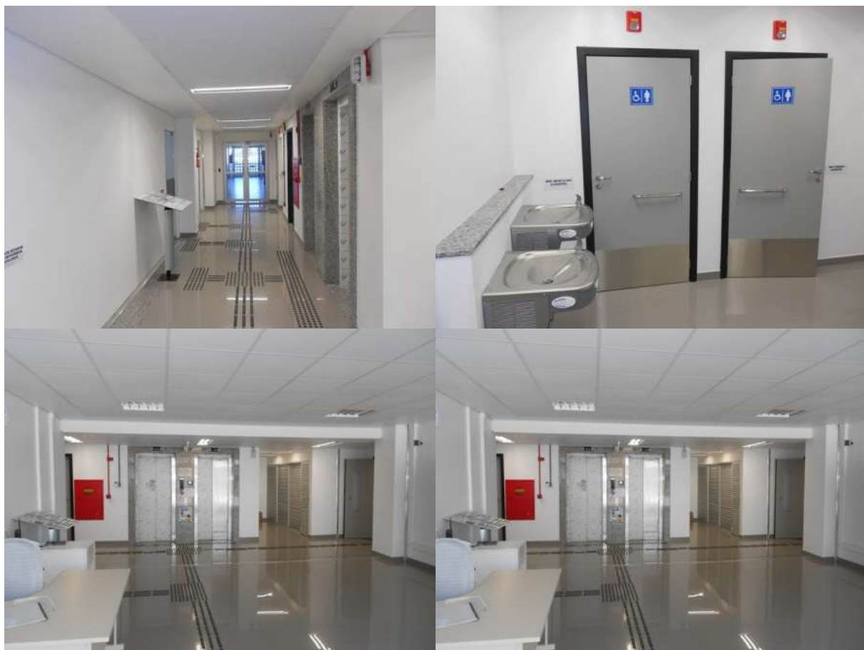
Figura 33 - Mosaico. Sinalização tátil. Bloco E/F e E Anexo do CFH
