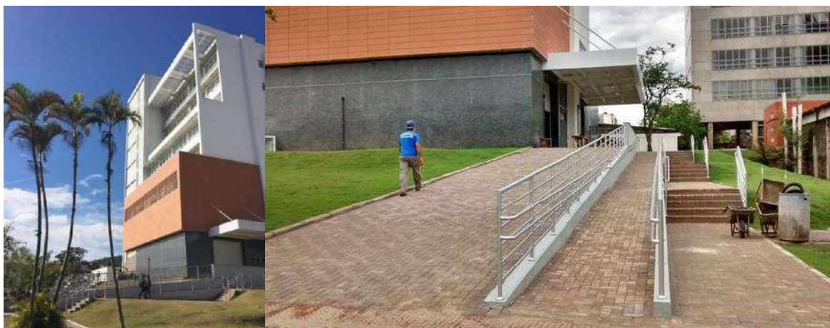
Figura 34 - Rampas de acessibilidade no CCE.
