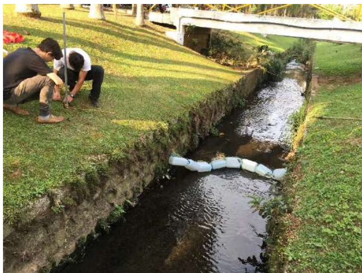
Figura 45 - Colocação da barreira de resíduos no Córrego Fonte: CGA (2020)
